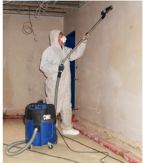
Abb. 7 Feinreinigung des Sanierungsbereiches
